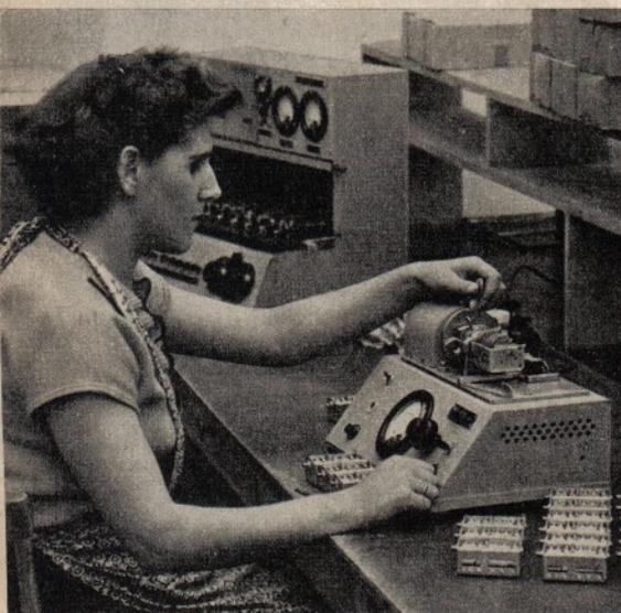
Abb. 3. Prüfgerät für Drehkondensatoren
