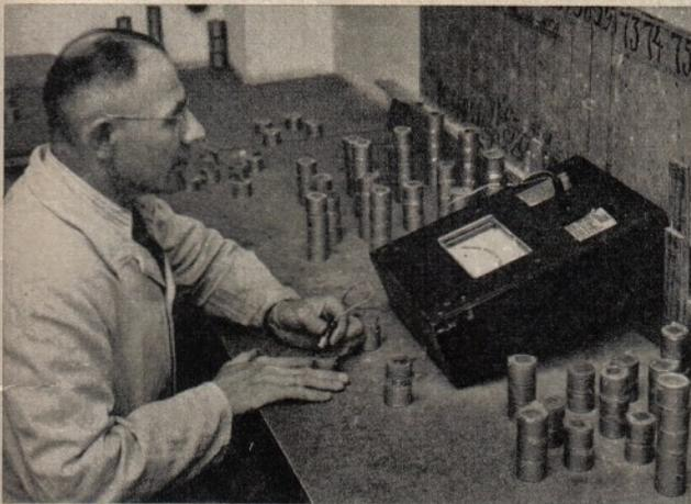
Abb. 6. Selengleichrichter-Prüfgerät
